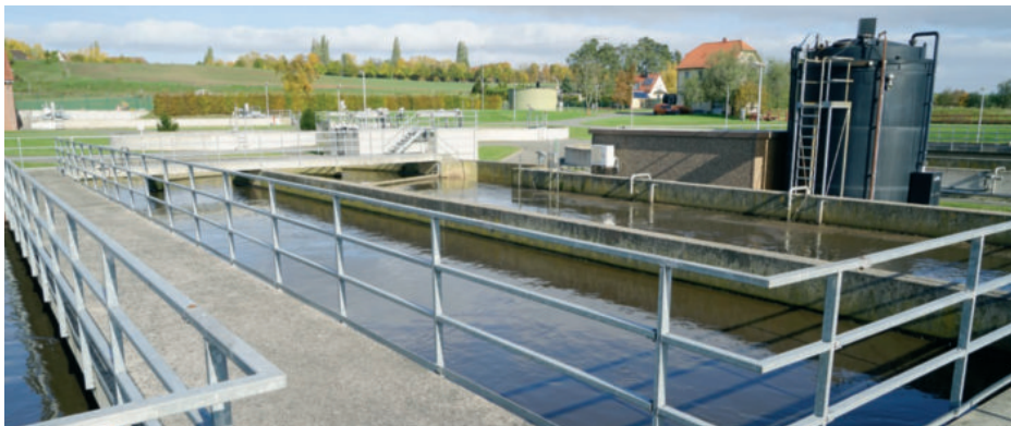
Kläranlage in Aschersleben
