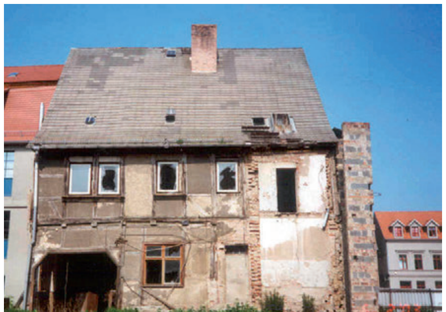
Die Hinterbreite 5 war mit einem zweigeschossigen Fachwerkhaus bebaut, welches schon im Jahr 2006 abgerissen wurde.
