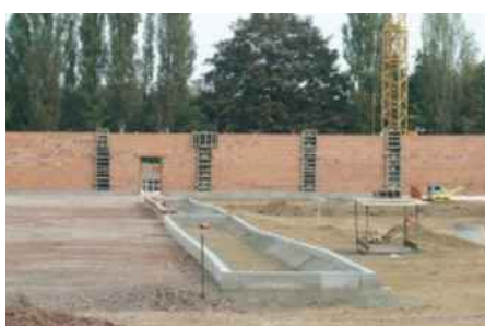
Bauarbeiten für die neuen Parkflächen
