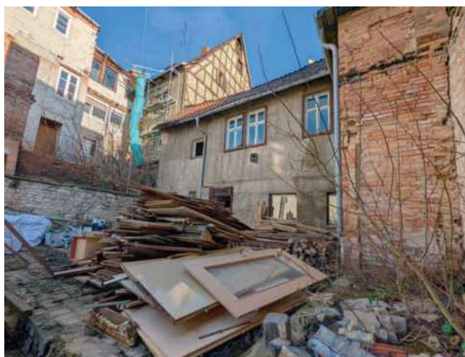
Entkernung Hohe Straße 19 - Hofansicht
