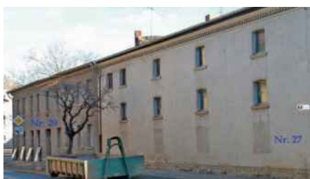
Heinrichstraße 27 und 29 vor dem Abriss
