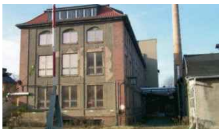
Betriebsgebäude Kindermoden im Jahr 2000
