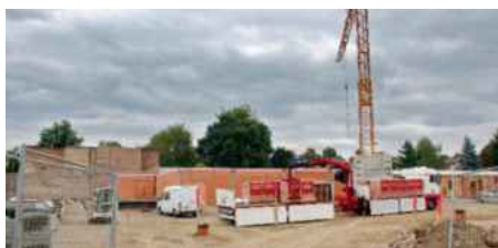
Bauphase Netto-Markt im Jahr 2008
