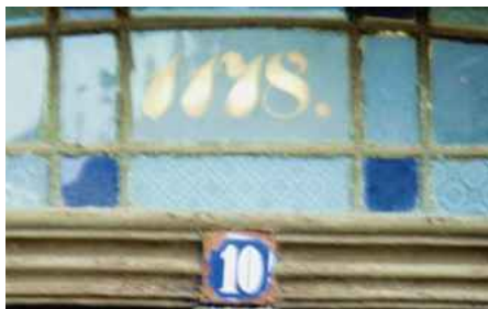
Oberlicht am Haus der Heinrichstraße 10
